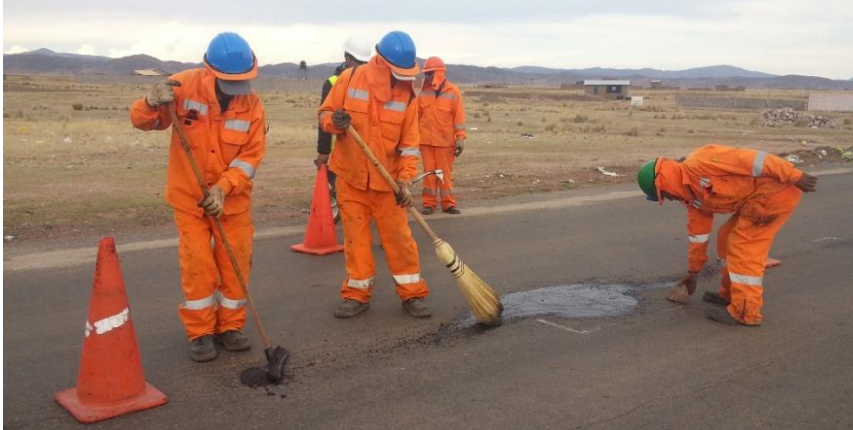
Figura 8. Fisuras con concreto.
