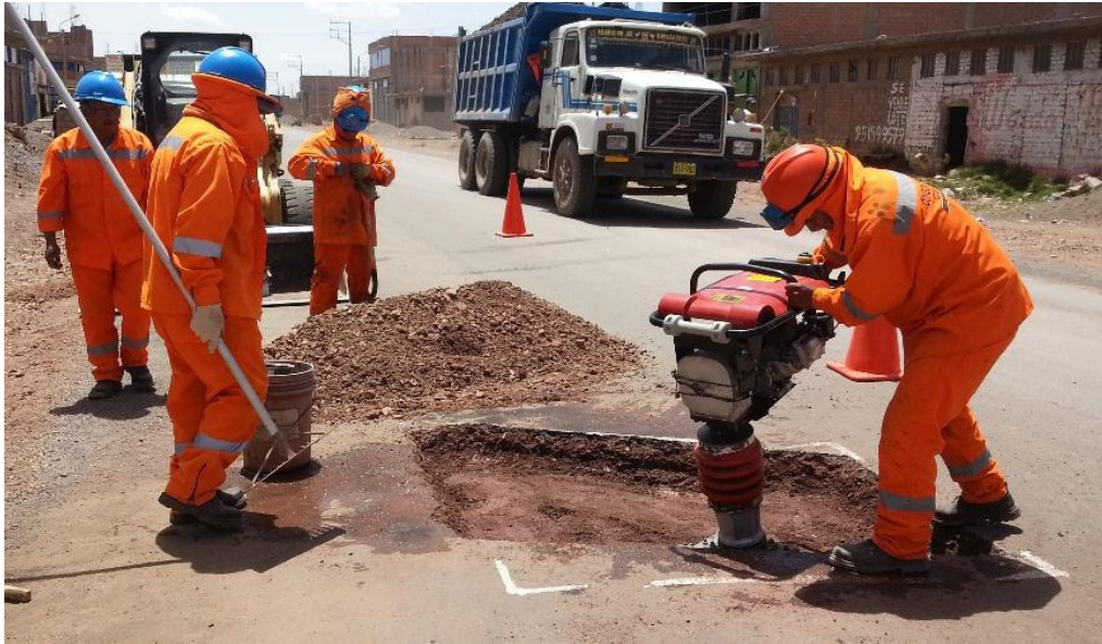
Figura 10. Capas de compactado.
