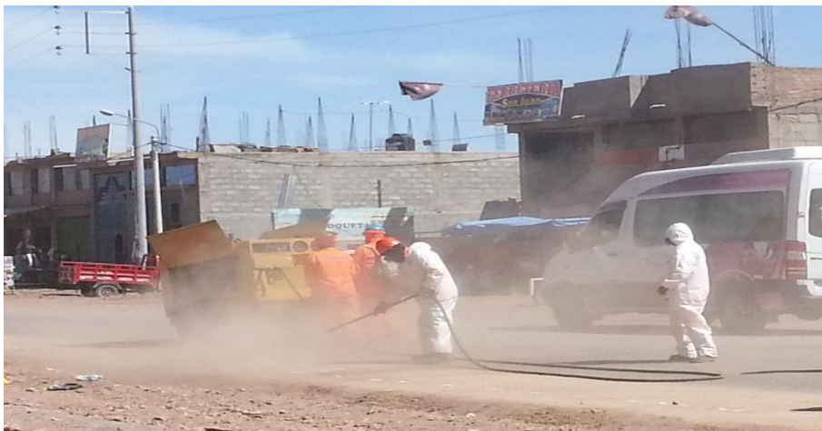
Figura 7. Proceso de limpieza de pavimento.
