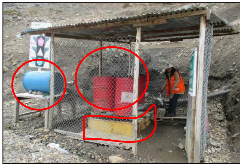
Figura N°34. Zona de Preparación del Floculante. Fuente: Proyecto de Exploración Minera Hilarión, (2015).
