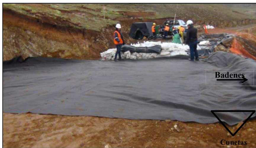
Figura N°36. Instalación del Geotextil No Tejido de 270 gr/m 2 . Fuente: Informe Maccaferri Proyecto de Exploración Hilarión, (2013).
