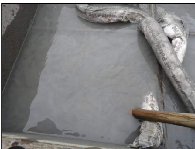
Figura N°45. Oil Absorbent Booms en el tanque de mezcla. Fuente: Proyecto de Exploración Hilarión, (2015).
