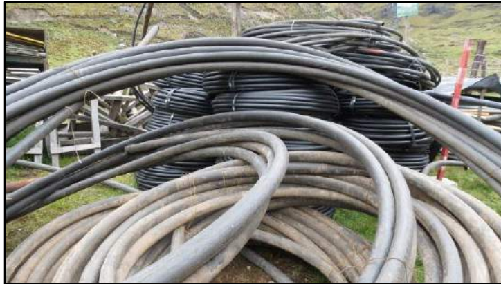
Figura N°31. Tuberías de HDPE y PVC. Fuente: Proyecto de Exploración Minera Hilarión, (2015).
