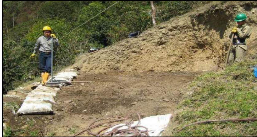
Figura N°03.- Diseño de la Plataforma de Perforación. Fuente: Compañía Minera CVS Exploración Ltda, (2008).
