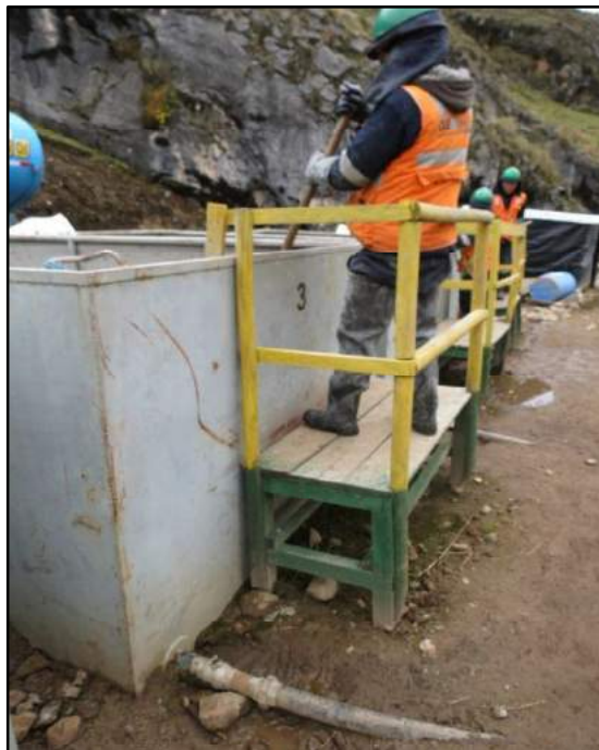
Figura N°44. Tanques de almacenamiento de lodos en movimiento. Fuente: Proyecto de Exploración Hilarión, (2015).
