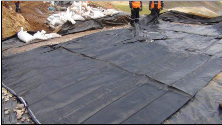
Figura N°40. Instalación de los Tubos de Geotextil Tejido. Fuente: Informe Maccaferri Proyecto de Exploración Hilarión, (2013).
