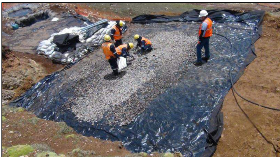
Figura N°38. Instalación de la Grava para el Drenaje. Fuente: Informe Maccaferri Proyecto de Exploración Hilarión, (2013).
