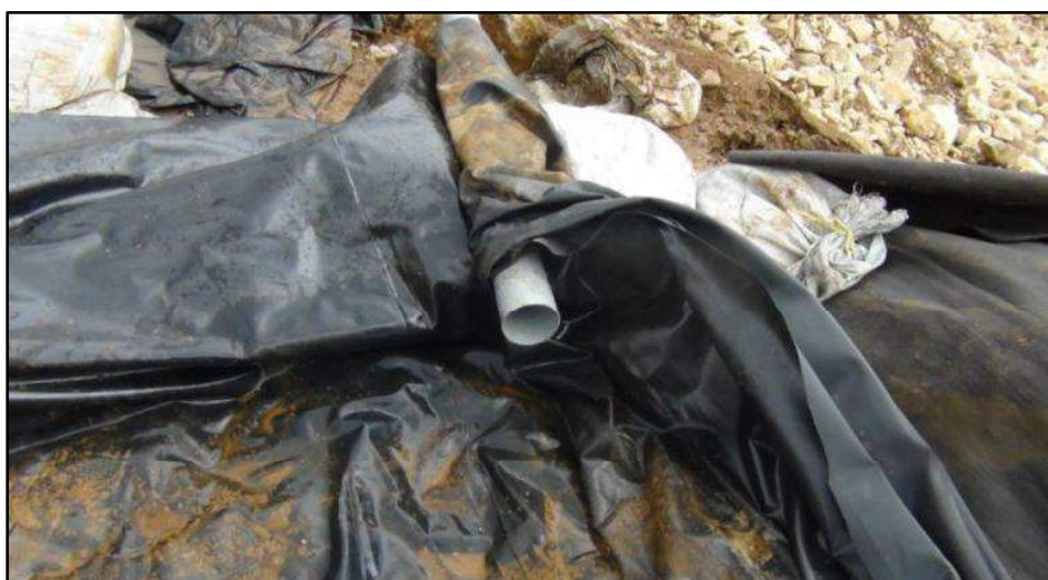
Figura N°39. Instalación de la red de tuberías. Fuente: Informe Maccaferri Proyecto de Exploración Hilarión, (2013).
