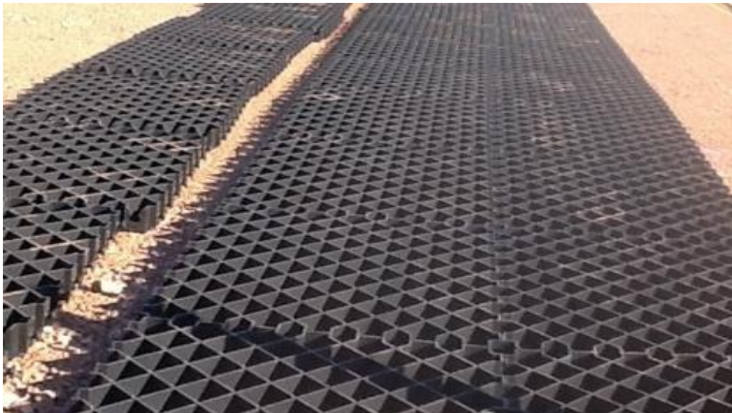
Instalación de geo celda
