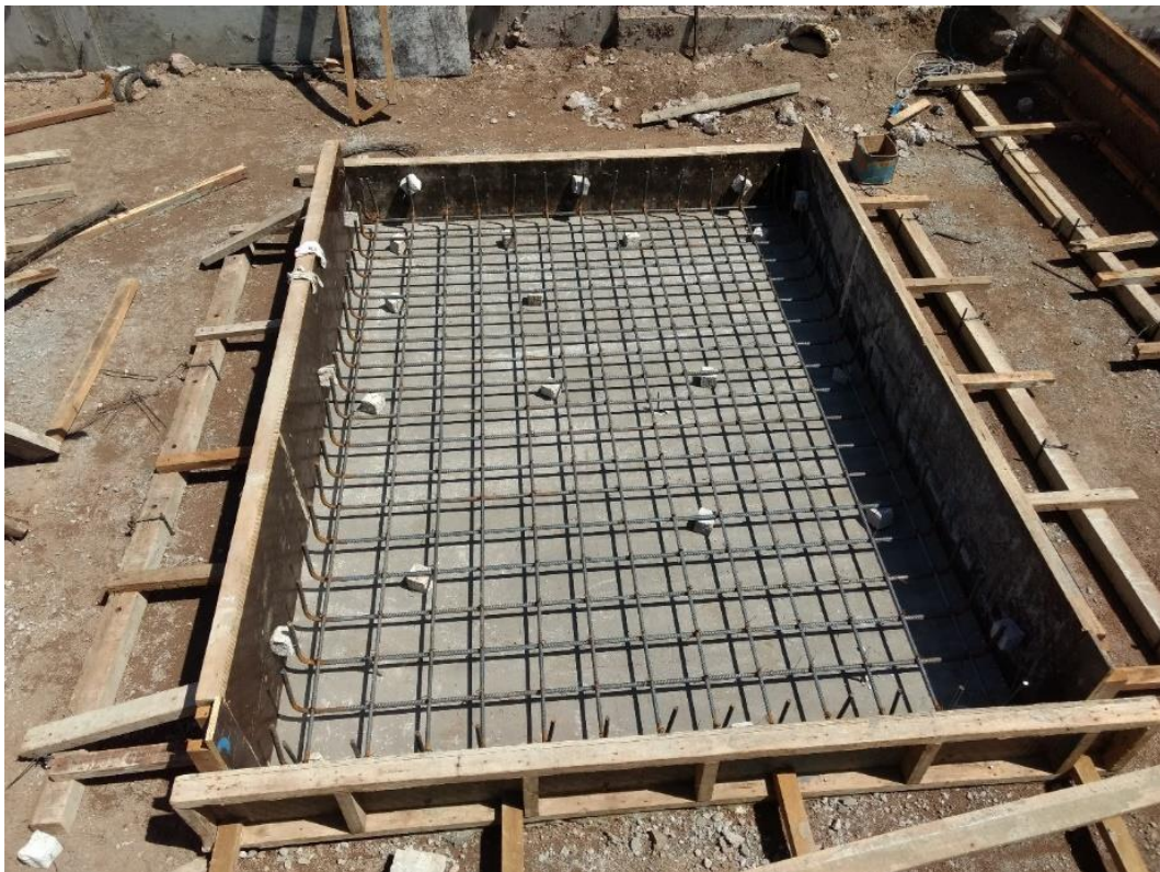
Encofrado de zapata
