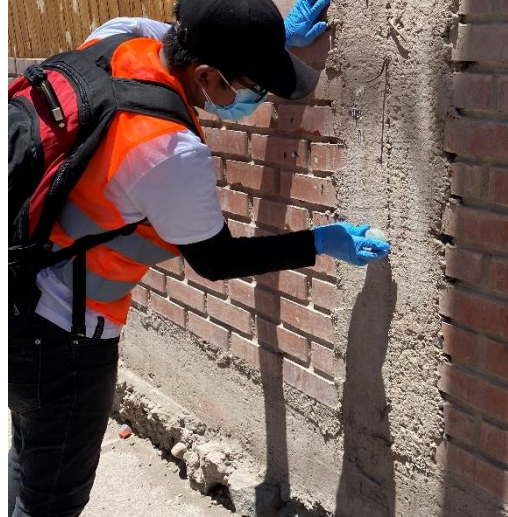
Figura 18. Pulido de superficie de concreto
