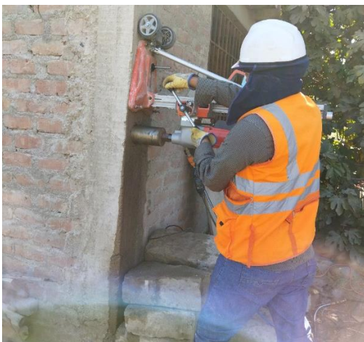
Figura 21. Extracción de diamantina en columna de concreto
