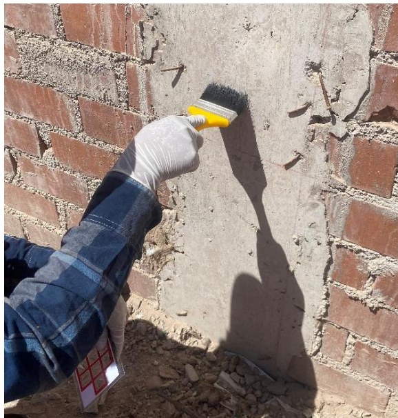
Figura 16. Limpieza de superficie de columna con brocha
