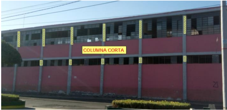
Figura 26. Elevación principal del pabellón P-3 de columnas cortas
