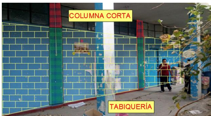
Figura 73. Elevación secundaria del pabellón P-3 del primer nivel
