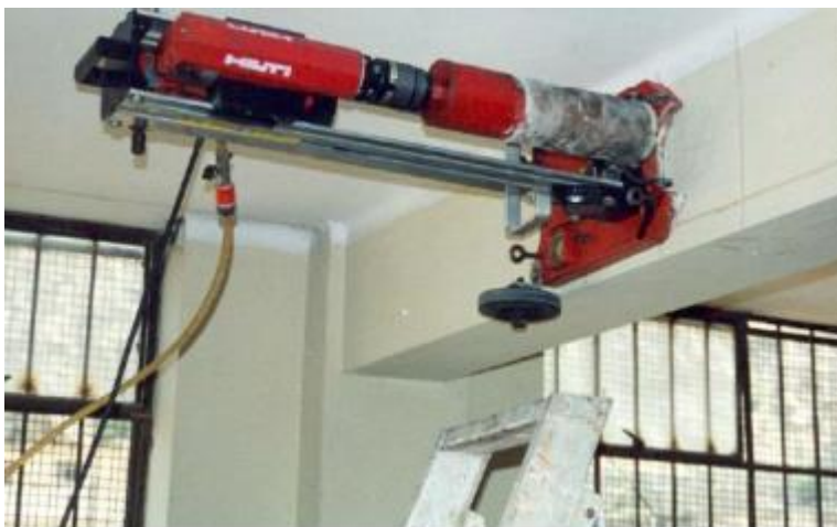
Figura 23. Equipo de perforación para la extracción de núcleos
