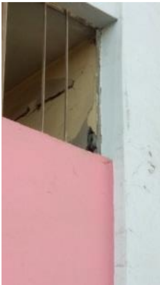
Figura 28. Interacción pórtico – tabique por fractura de tabique
