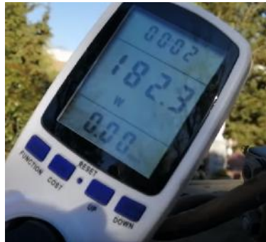
Figura 2 Medición luminaria vsap 150 W.
