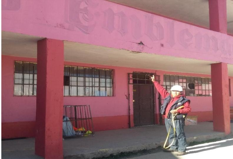
Figura 15. Muros en sentido X-X pasadizo presenta fisuras
