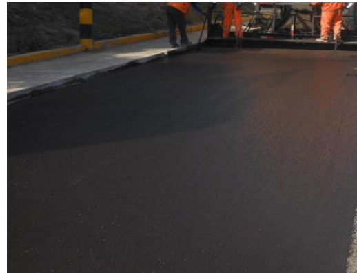
Figura 98. Aplicación del slurry seal en lado derecho de la berma con uso de camión micropavimentador en la Av. Malecón Ribereño, progresiva 1+160 @ 2+160
