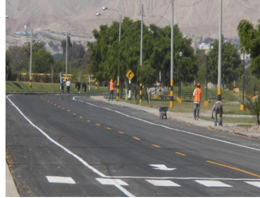
Figura 62. Repintado de señales horizontales: Líneas de borde de la Av. Malecón Ribereño, progresiva 1+160 @ 2+160
