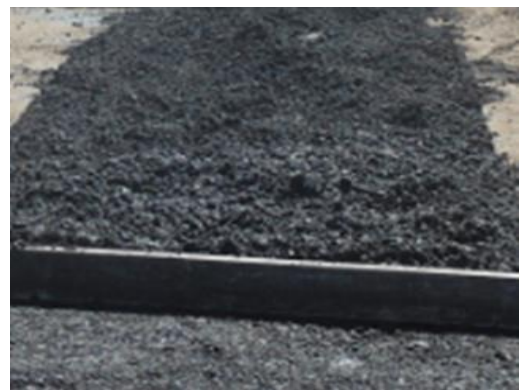
Figura 68. Imprimación del material de la base granular, extensión y compactación de la mezcla asfáltica, progresiva 0+620
