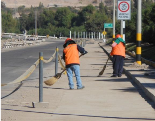
Figura 93. Limpieza y barrido de la superficie antes de la imprimación de las bermas en la Av. Malecón Ribereño, progresiva 1+160 @ 2+160
