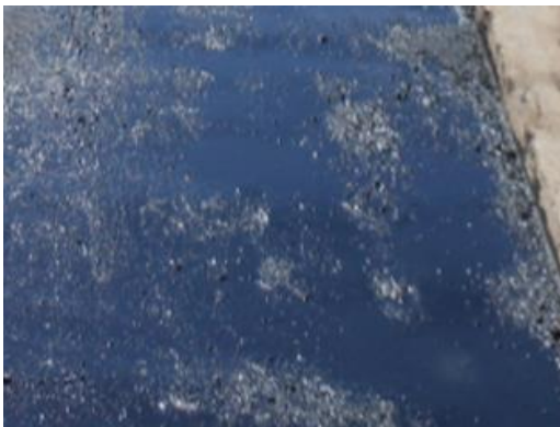
Figura 68. Imprimación del material de la base granular, extensión y compactación de la mezcla asfáltica, progresiva 0+620
