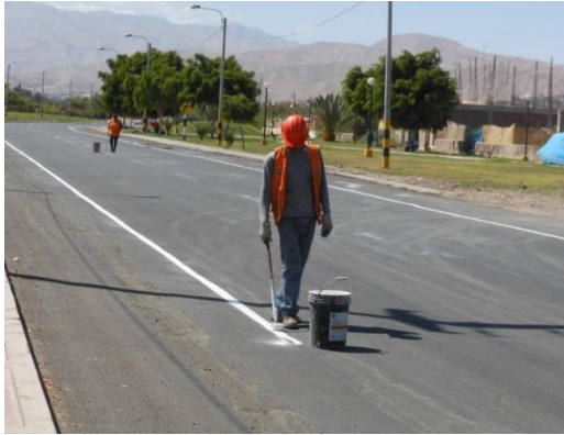
Figura 62. Repintado de señales horizontales: Líneas de borde de la Av. Malecón Ribereño, progresiva 1+160 @ 2+160
