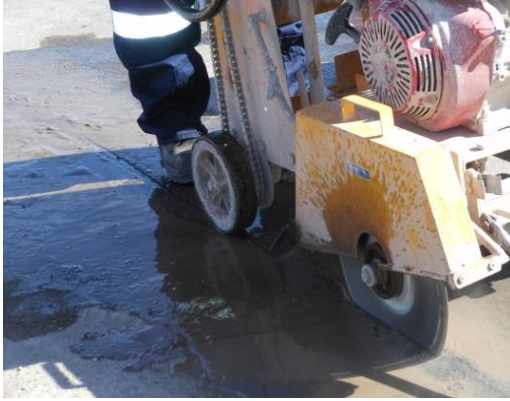
Figura 72. Bacheo 3: Corte, demolición y excavación de la carpeta asfáltica del tipo de daño desprendimiento A de 50,00 m 2 , progresiva 3+360
