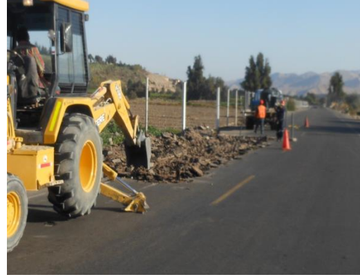
Figura 72. Bacheo 3: Corte, demolición y excavación de la carpeta asfáltica del tipo de daño desprendimiento A de 50,00 m 2 , progresiva 3+360
