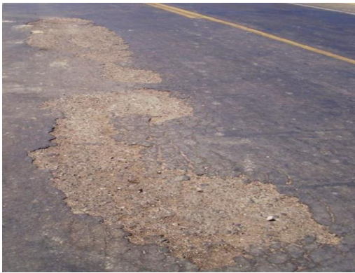
Figura 52. Tercer tipo de daño denominado desprendimiento ubicado en la progresiva 3+360
