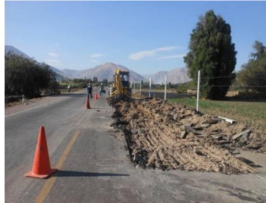
Figura 75. Bacheo 4: Corte, demolición y excavación de la carpeta asfáltica del tipo de daño desprendimiento B de 47,50 m 2 , progresiva 3+700
