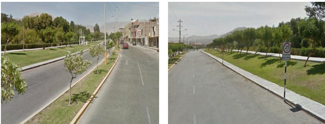
Figura 37. Elementos de la vía que no presentan daños significativos entre la progresiva 0+000 a la progresiva 0+500
