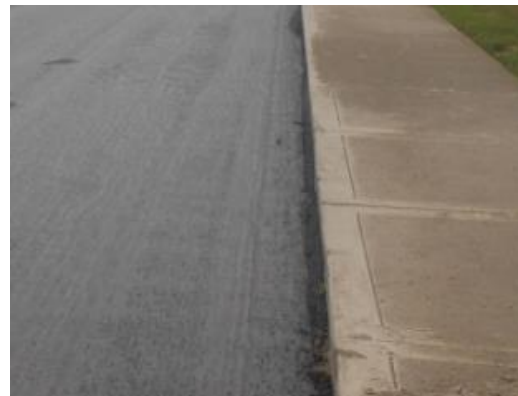
Figura 99. Aplicación del slurry seal en lado izquierdo de la berma con uso de camión micropavimentador en la Av. Malecón Ribereño, progresiva 1+160 @ 2+160
