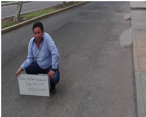
Figura 104. Bacheo asfáltico en el tipo de daño piel de cocodrilo realizado en julio del año 2014 en la Av. Malecón Ribereño progresiva 0+620
