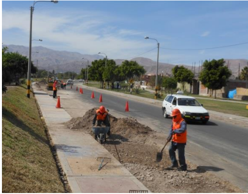
Figura 86. Remoción de la base deteriorada, lado derecho de la berma de la Av. Malecón Ribereño, progresiva 1+160 @ 2+160
