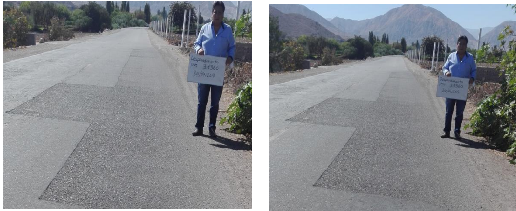
Figura 106. Bacheo asfáltico en el tipo de daño desprendimiento reparado en julio del año 2014 en la Av. Malecón Ribereño progresiva 3+360
