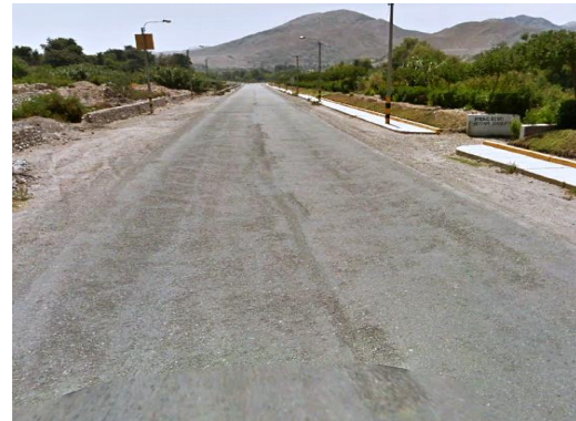
Figura 46. Desgaste significativo de la carpeta asfáltica ubicado desde la progresiva 2+000 a la progresiva 2+160
