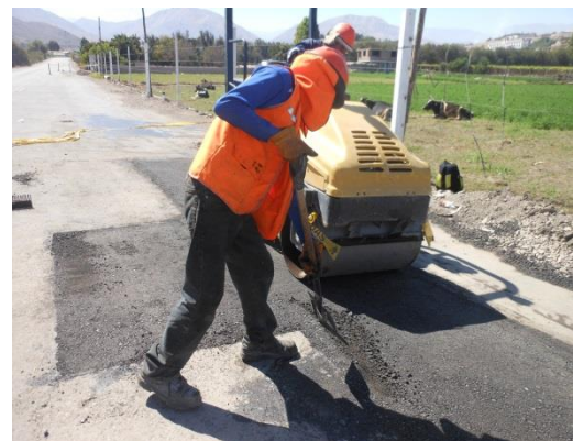
Figura 74. Imprimación del material de la base granular, extensión y compactación de la mezcla asfáltica, progresiva 3+360
