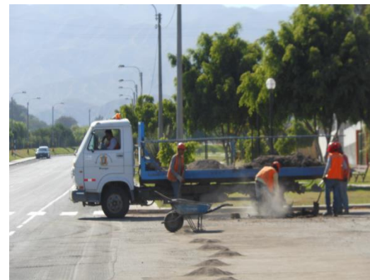
Figura 60. Traslado y eliminación al botadero de los residuos sólidos de la Av. Malecón Ribereño
