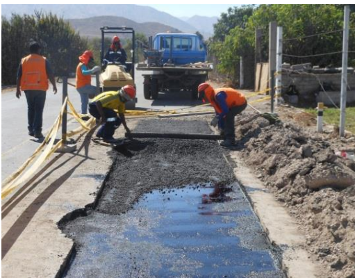
Figura 77. Imprimación del material de la base granular, extensión y compactación de la mezcla asfáltica, progresiva 3+700
