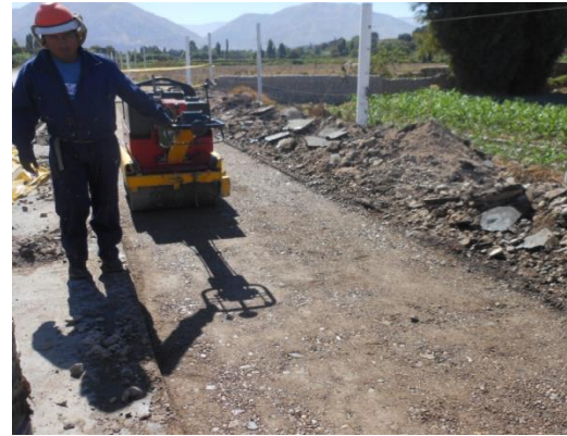
Figura 76. Reemplazo, nivelación y compactación del material de la base granular, progresiva 3+700
