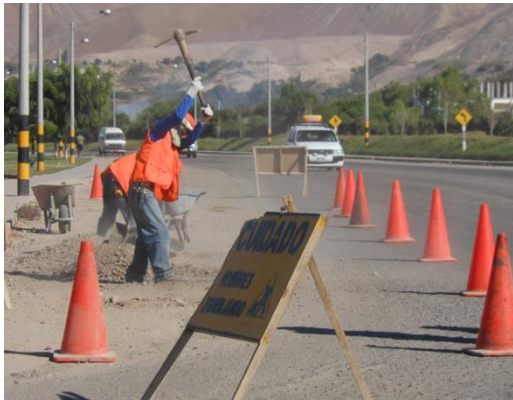
Figura 87. Remoción de la base deteriorada, lado izquierdo de la berma de la Av. Malecón Ribereño, progresiva 1+160 @ 2+160
