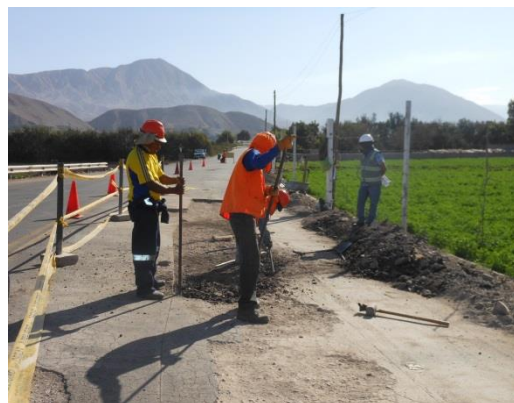
Figura 78. Bacheo 5: Corte, demolición y excavación de la carpeta asfáltica del tipo de daño desprendimiento C de 40,00 m 2 , progresiva 3+740
