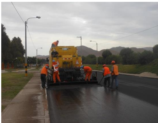
Figura 99. Aplicación del slurry seal en lado izquierdo de la berma con uso de camión micropavimentador en la Av. Malecón Ribereño, progresiva 1+160 @ 2+160
