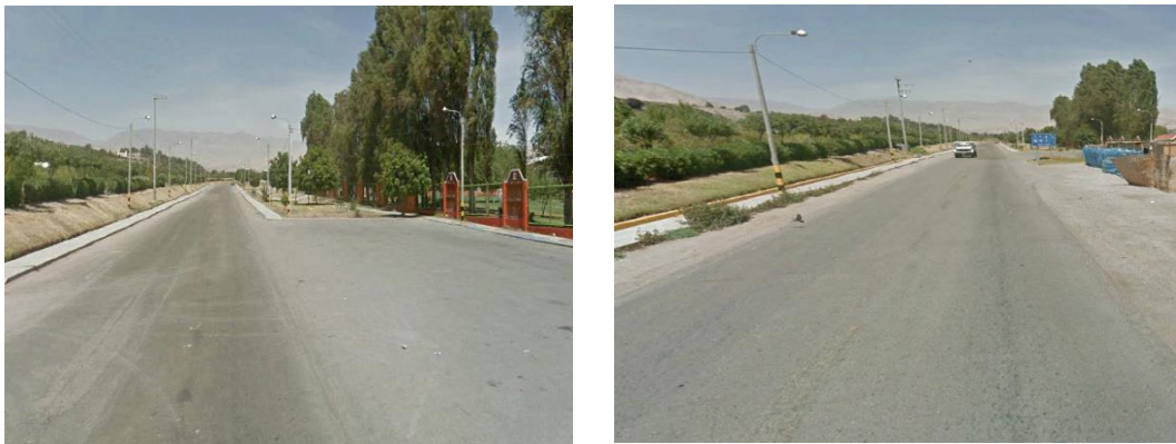
Figura 45. Señalización horizontal de manera defectuosa ubicada desde la progresiva 1+500 a la progresiva 2+000
