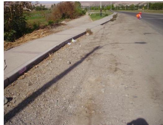
Figura 40. Deterioro de las bermas ubicado desde la progresiva 1+160 a la progresiva 1+500
