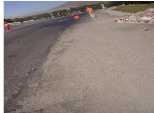
Figura 47. Deterioro de las bermas ubicado desde la progresiva 2+000 a la progresiva 2+160
