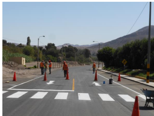
Figura 64. Repintado de señales horizontales: Pase peatonal y símbolos de la Av. Malecón Ribereño, progresiva 1+160 @ 2+160
