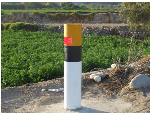
Figura 103. Reposición de los postes delineadores en la Av. Malecón Ribereño, progresiva 2+180 @ 4+300
