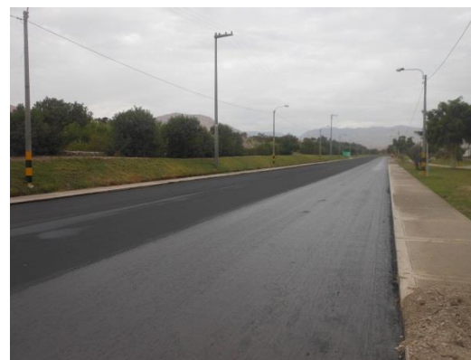
Figura 84. Culminación de la aplicación del sello asfáltico en la superficie del pavimento en la Av. Malecón Ribereño, progresiva 1+160 @ 2+160
