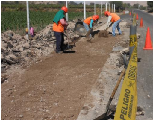
Figura 76. Reemplazo, nivelación y compactación del material de la base granular, progresiva 3+700
