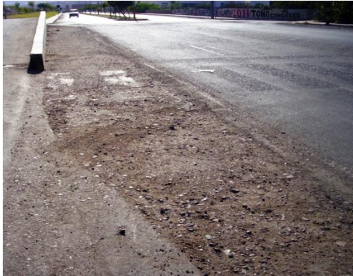
Figura 39. Desgaste significativo de la carpeta asfáltica ubicado desde la progresiva 1+160 a la progresiva 1+500
