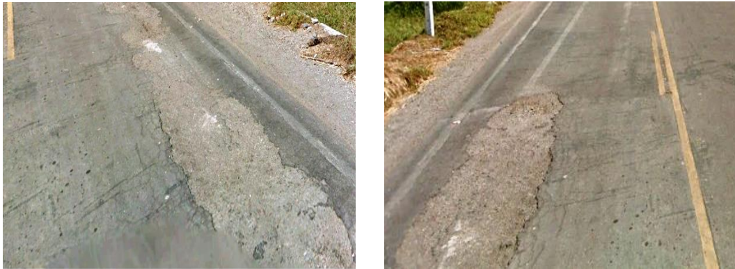
Figura 54. Tipo de daño denominado desprendimiento ubicado en la progresiva 3+700
