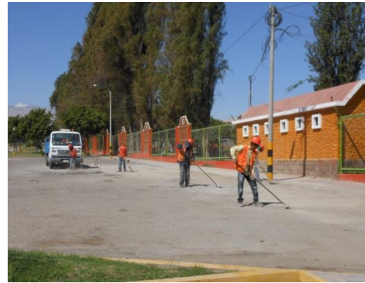
Figura 58. Barrido y remoción de residuos sólidos de la carpeta asfáltica Av. Malecón Ribereño
