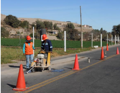
Figura 75. Bacheo 4: Corte, demolición y excavación de la carpeta asfáltica del tipo de daño desprendimiento B de 47,50 m 2 , progresiva 3+700
