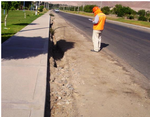
Figura 40. Deterioro de las bermas ubicado desde la progresiva 1+160 a la progresiva 1+500
