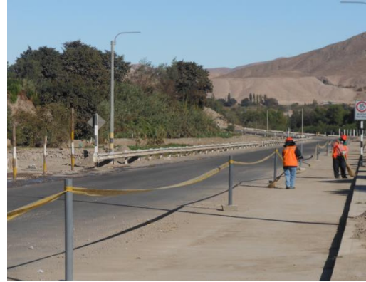
Figura 93. Limpieza y barrido de la superficie antes de la imprimación de las bermas en la Av. Malecón Ribereño, progresiva 1+160 @ 2+160
