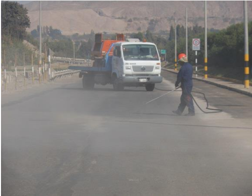
Figura 82. Limpieza total de la superficie del pavimento con uso de compresora de aire en la Av. Malecón Ribereño, progresiva 1+160 @ 2+160
