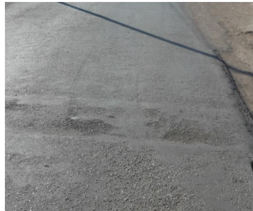
Figura 42. Segundo tipo de daño denominado ahuellamiento ubicado en la progresiva 1+645
