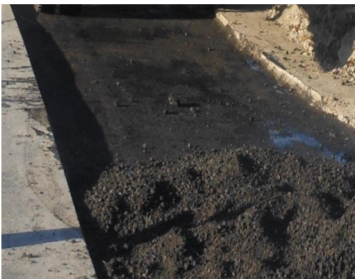
Figura 74. Imprimación del material de la base granular, extensión y compactación de la mezcla asfáltica, progresiva 3+360
