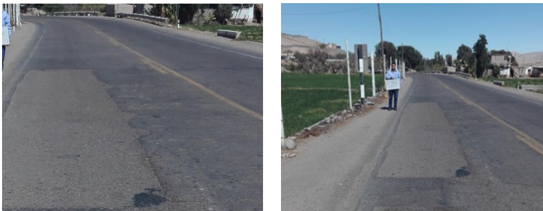
Figura 107. Bacheo asfáltico en el tipo de daño desprendimiento reparado en julio del año 2014 en la Av. Malecón Ribereño progresiva 3+700
