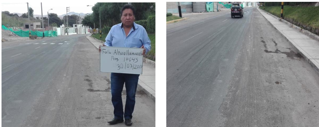
Figura 105. Bacheo asfáltico en el tipo de daño ahuellamiento reparado en julio del año 2014 en la Av. Malecón Ribereño progresiva 1+645
