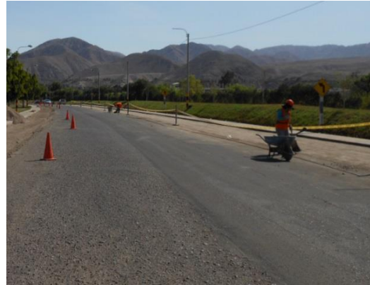
Figura 39. Desgaste significativo de la carpeta asfáltica ubicado desde la progresiva 1+160 a la progresiva 1+500
