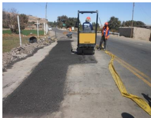
Figura 80. Imprimación del material de la base granular, extensión y compactación de la mezcla asfáltica, progresiva 3+740
