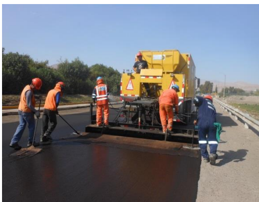
Figura 84. Culminación de la aplicación del sello asfáltico en la superficie del pavimento en la Av. Malecón Ribereño, progresiva 1+160 @ 2+160
