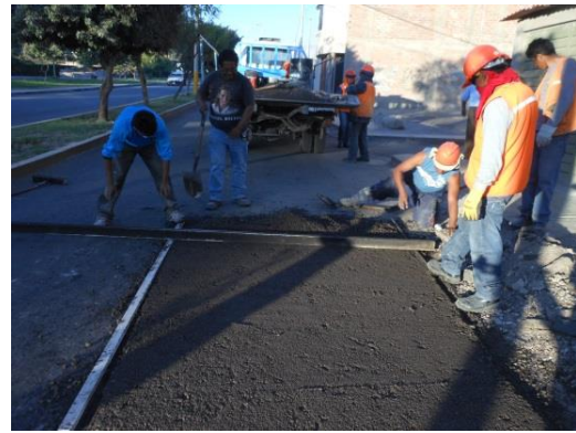
Figura 67. Reemplazo, nivelación y compactación del material de la base granular, progresiva 0+620
