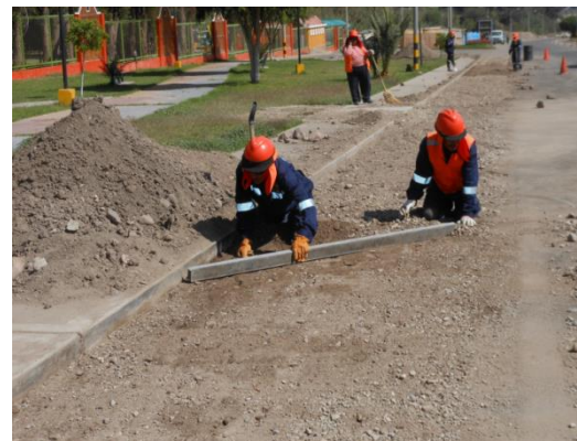
Figura 88. Extensión del material granular preparado y batido, a ambos lados de la berma de la Av. Malecón Ribereño, progresiva 1+160 @ 2+160
