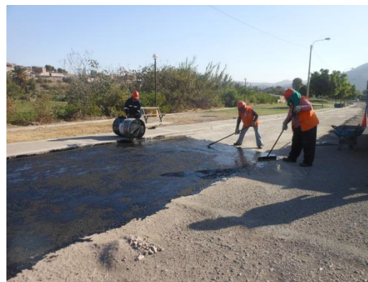
Figura 95. Aplicación de asfalto líquido, MC-30 al lado izquierdo de la berma de la Av. Malecón Ribereño, progresiva 1+160 @ 2+160
