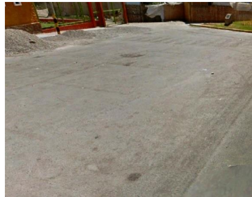
Figura 43. Desgaste significativo de la carpeta asfáltica ubicado desde la progresiva 1+500 a la progresiva 2+000
