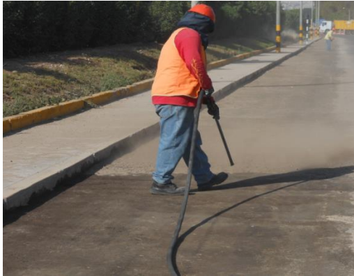
Figura 97. Limpieza total de la superficie de las bermas con uso de compresora de aire en la Av. Malecón Ribereño, progresiva 1+160 @ 2+160
