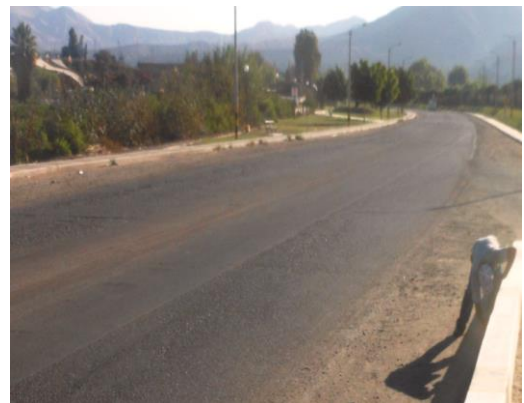
Figura 41. Señalización horizontal de manera defectuosa ubicada desde la progresiva 1+160 a la progresiva 1+500
