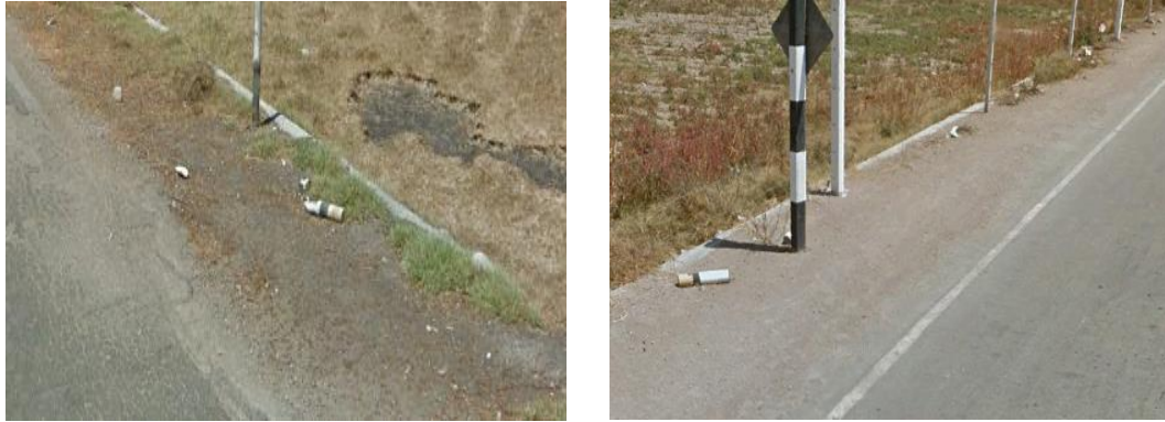
Figura 50. Mal estado de los postes delineadores ubicado entre la progresiva 2+500 a la progresiva 3+000
