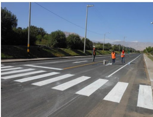
Figura 64. Repintado de señales horizontales: Pase peatonal y símbolos de la Av. Malecón Ribereño, progresiva 1+160 @ 2+160
