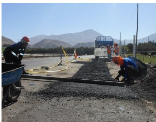
Figura 80. Imprimación del material de la base granular, extensión y compactación de la mezcla asfáltica, progresiva 3+740
