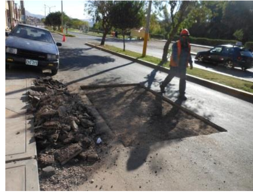
Figura 66. Bacheo 1: Corte, demolición y excavación de la carpeta asfáltica del tipo de daño piel cocodrilo de 21,60 m 2 , progresiva 0+620
