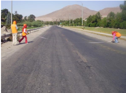
Figura 46. Desgaste significativo de la carpeta asfáltica ubicado desde la progresiva 2+000 a la progresiva 2+160
