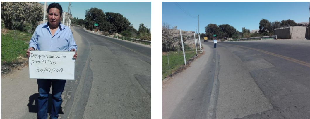
Figura 108. Bacheo asfáltico en el tipo de daño desprendimiento reparado en julio del año 2014 en la Av. Malecón Ribereño progresiva 3+740
