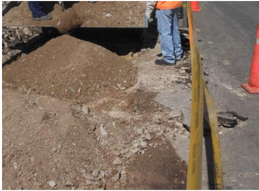
Figura 70. Reemplazo, nivelación y compactación del material de la base granular, progresiva 1+645
