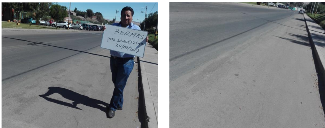
Figura 110. Tratamiento de bermas realizada en junio del año 2014 en la Av. Malecón Ribereño progresiva, 1+160 @ 2+160
