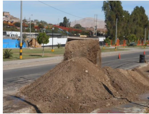
Figura 86. Remoción de la base deteriorada, lado derecho de la berma de la Av. Malecón Ribereño, progresiva 1+160 @ 2+160
