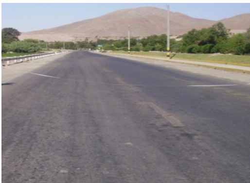
Figura 48. Señalización horizontal de manera defectuosa ubicada desde la progresiva 2+000 a la progresiva 2+160
