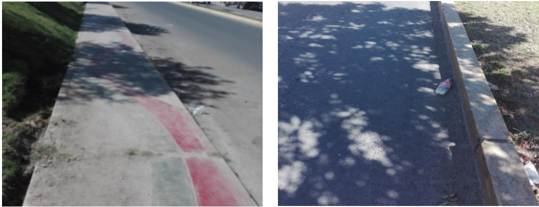
Figura 36. Presencia de residuos sólidos en proporciones pequeñas desde la progresiva 0+000 a la progresiva 0+500
