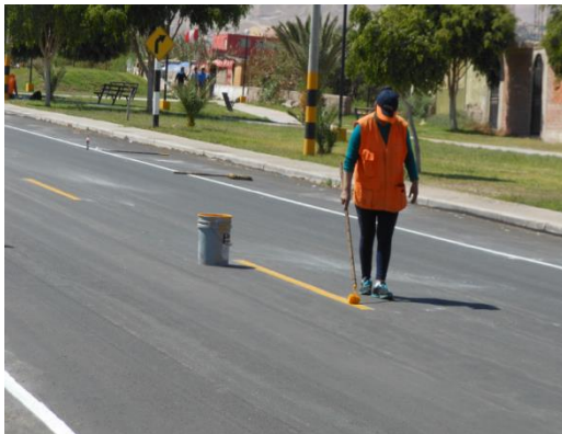
Figura 63. Repintado de señales horizontales: Línea central de la Av. Malecón Ribereño, progresiva 1+160 @ 2+160
