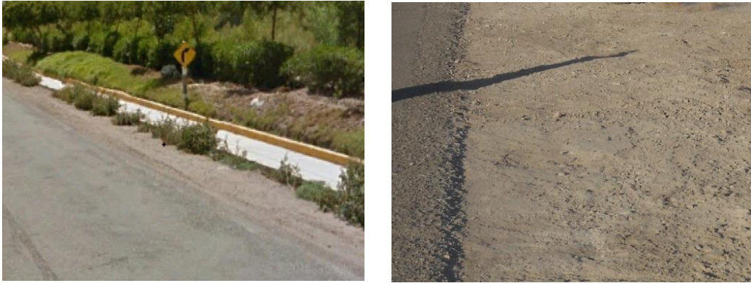
Figura 44. Deterioro de las bermas ubicado desde la progresiva 1+500 a la progresiva 2+000
