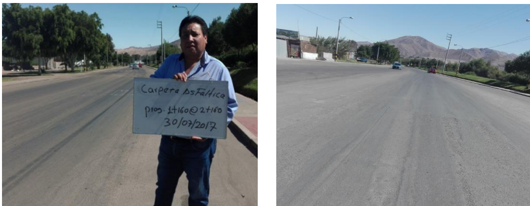
Figura 109. Carpeta asfáltica impermeabilizada y rejuvenecida con aplicación de sello asfáltico en agosto del año 2014 en la Av. Malecón Ribereño progresiva, 1+160 @ 2+160
