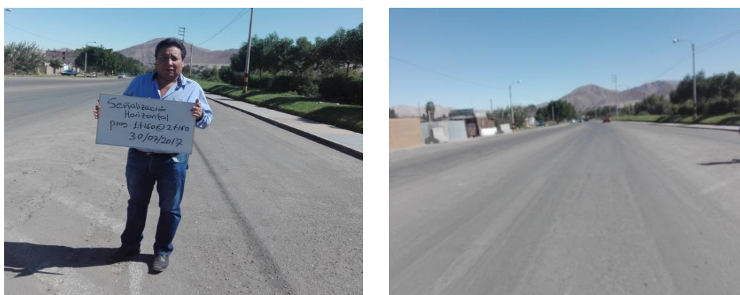
Figura 111. Repintado de señales horizontales realizada en agosto del año 2014 en la Av. Malecón Ribereño progresiva, 1+160 @ 2+160
