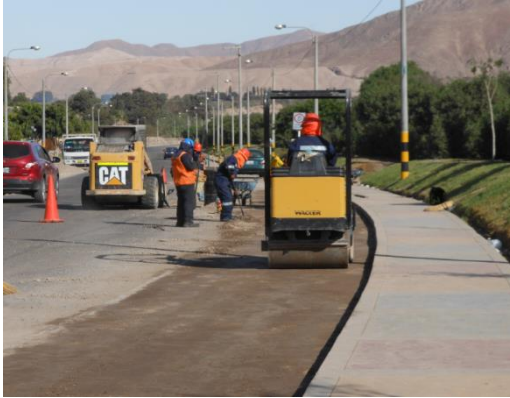
Figura 89. Compactación y conformación de la capa base de ambos lados de la berma de la Av. Malecón Ribereño, progresiva 1+160 @ 2+160
