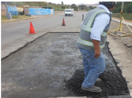
Figura 71. Imprimación del material de la base granular, extensión y compactación de la mezcla asfáltica, progresiva 1+645
