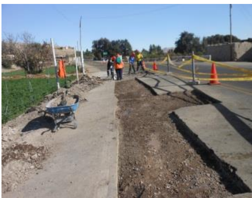
Figura 79. Reemplazo, nivelación y compactación del material de la base granular, progresiva 3+740
