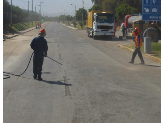
Figura 82. Limpieza total de la superficie del pavimento con uso de compresora de aire en la Av. Malecón Ribereño, progresiva 1+160 @ 2+160
