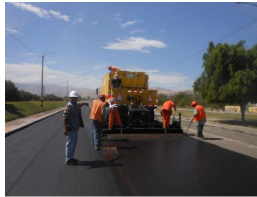
Figura 83. Aplicación del sello asfáltico en la superficie del pavimento con uso de camión micropavimentador en la Av. Malecón Ribereño, progresiva 1+160 @ 2+160
