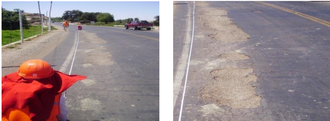
Figura 55. Tipo de daño denominado desprendimiento ubicado en la progresiva 3+740
