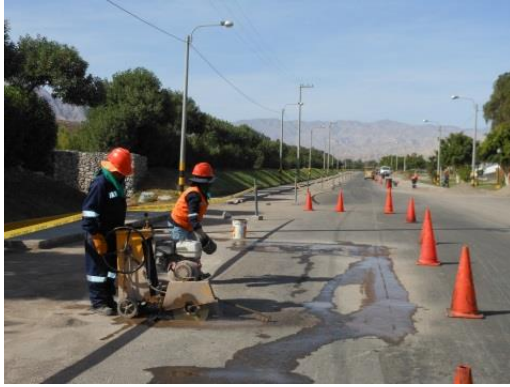
Figura 69. Bacheo 2: Corte, demolición y excavación de la carpeta asfáltica del tipo de daño ahuellamiento de 14,00 m 2 , progresiva 1+645
