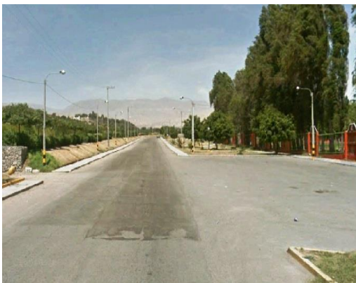
Figura 43. Desgaste significativo de la carpeta asfáltica ubicado desde la progresiva 1+500 a la progresiva 2+000
