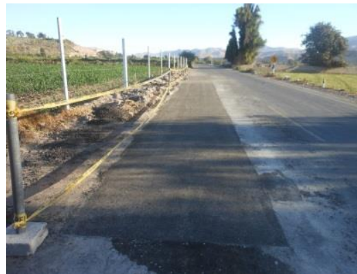
Figura 77. Imprimación del material de la base granular, extensión y compactación de la mezcla asfáltica, progresiva 3+700
