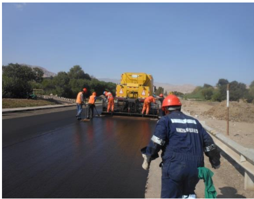
Figura 83. Aplicación del sello asfáltico en la superficie del pavimento con uso de camión micropavimentador en la Av. Malecón Ribereño, progresiva 1+160 @ 2+160
