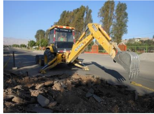
Figura 69. Bacheo 2: Corte, demolición y excavación de la carpeta asfáltica del tipo de daño ahuellamiento de 14,00 m 2 , progresiva 1+645
