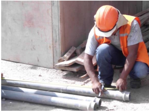
Figura 101. Cortado de tubos de PVC y preparación de los postes delineadores
