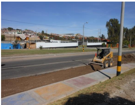
Figura 88. Extensión del material granular preparado y batido, a ambos lados de la berma de la Av. Malecón Ribereño, progresiva 1+160 @ 2+160
