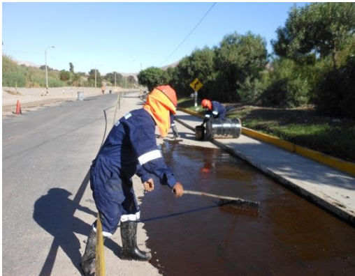
Figura 94. Aplicación de asfalto líquido, MC-30 al lado derecho de la berma de la Av. Malecón Ribereño, progresiva 1+160 @ 2+160
