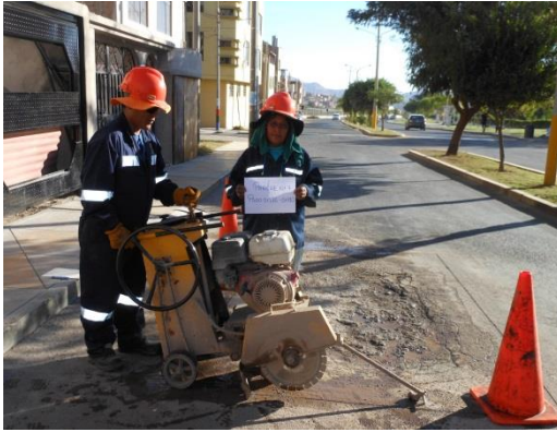
Figura 66. Bacheo 1: Corte, demolición y excavación de la carpeta asfáltica del tipo de daño piel cocodrilo de 21,60 m 2 , progresiva 0+620
