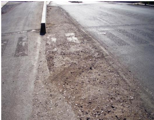
Figura 41. Señalización horizontal de manera defectuosa ubicada desde la progresiva 1+160 a la progresiva 1+500
