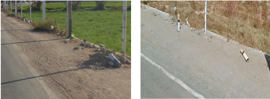
Figura 49. Mal estado de los postes delineadores ubicado entre la progresiva 2+180 a la progresiva 2+500
