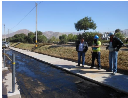
Figura 94. Aplicación de asfalto líquido, MC-30 al lado derecho de la berma de la Av. Malecón Ribereño, progresiva 1+160 @ 2+160
