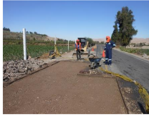
Figura 73. Reemplazo, nivelación y compactación del material de la base granular, progresiva 3+360
