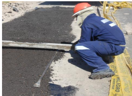
Figura 71. Imprimación del material de la base granular, extensión y compactación de la mezcla asfáltica, progresiva 1+645
