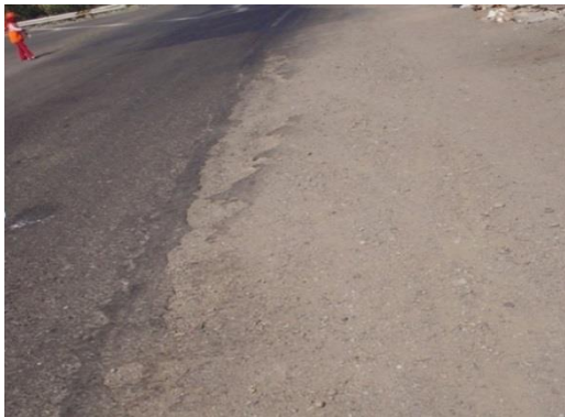
Figura 47. Deterioro de las bermas ubicado desde la progresiva 2+000 a la progresiva 2+160
