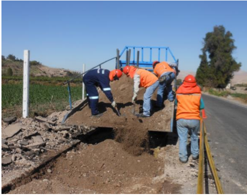
Figura 73. Reemplazo, nivelación y compactación del material de la base granular, progresiva 3+360
