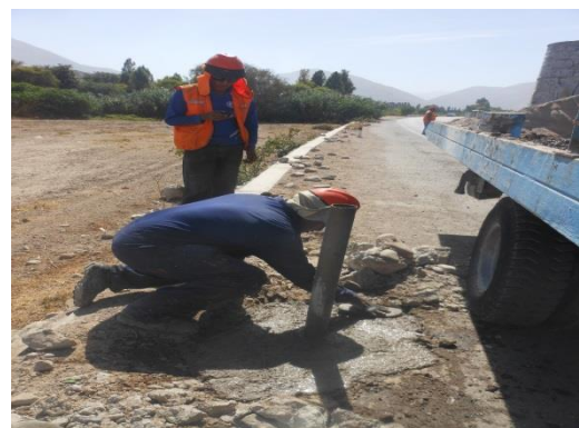
Figura 102. Instalación y fijación de los postes delineadores en la Av. Malecón Ribereño, progresiva 2+180 @ 4+300
