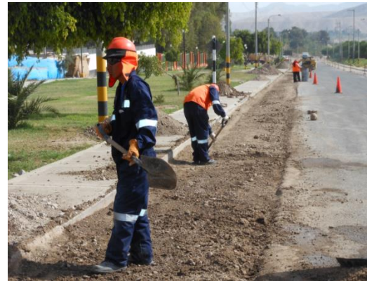
Figura 87. Remoción de la base deteriorada, lado izquierdo de la berma de la Av. Malecón Ribereño, progresiva 1+160 @ 2+160
