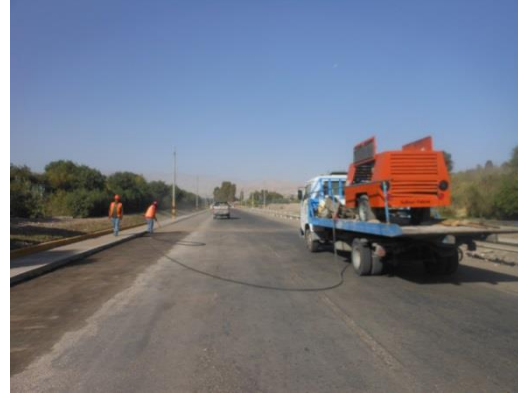
Figura 97. Limpieza total de la superficie de las bermas con uso de compresora de aire en la Av. Malecón Ribereño, progresiva 1+160 @ 2+160
