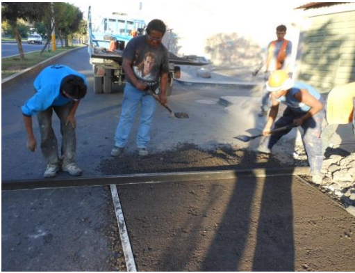
Figura 67. Reemplazo, nivelación y compactación del material de la base granular, progresiva 0+620
