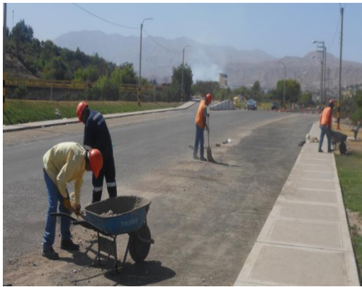
Figura 58. Barrido y remoción de residuos sólidos de la carpeta asfáltica Av. Malecón Ribereño
