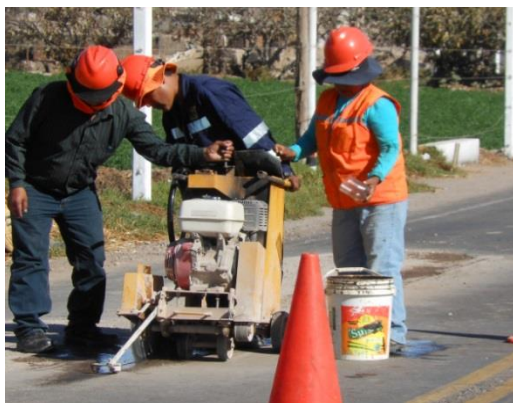
Figura 78. Bacheo 5: Corte, demolición y excavación de la carpeta asfáltica del tipo de daño desprendimiento C de 40,00 m 2 , progresiva 3+740
