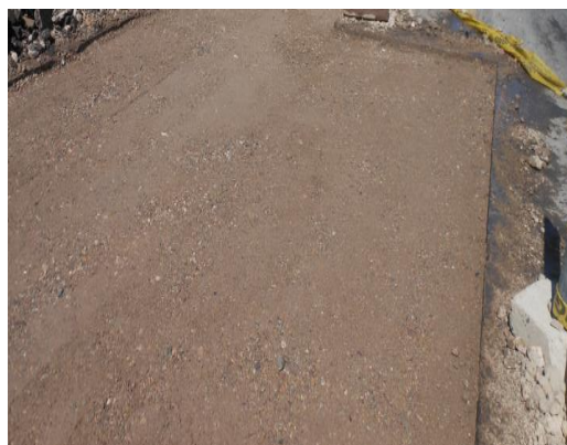
Figura 79. Reemplazo, nivelación y compactación del material de la base granular, progresiva 3+740
