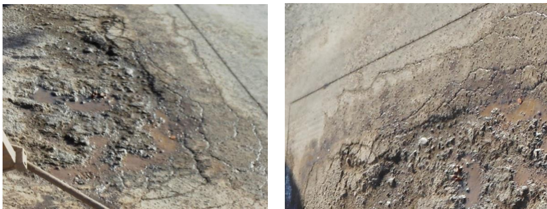
Figura 38. Primer tipo de daño denominado piel de cocodrilo ubicado entre la progresiva 0+620
