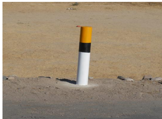
Figura 103. Reposición de los postes delineadores en la Av. Malecón Ribereño, progresiva 2+180 @ 4+300
