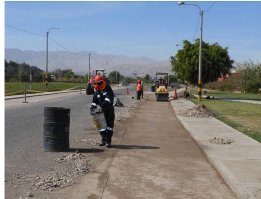
Figura 89. Compactación y conformación de la capa base de ambos lados de la berma de la Av. Malecón Ribereño, progresiva 1+160 @ 2+160
