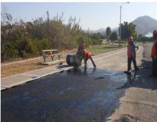
Figura 95. Aplicación de asfalto líquido, MC-30 al lado izquierdo de la berma de la Av. Malecón Ribereño, progresiva 1+160 @ 2+160
