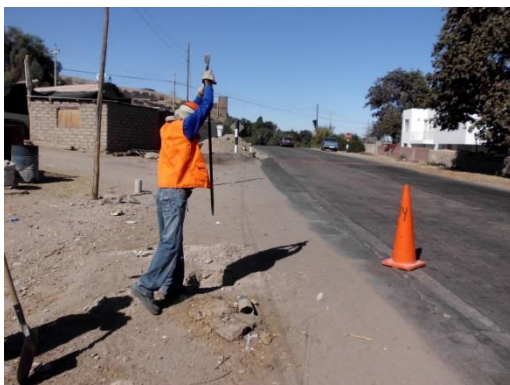
Figura 102. Instalación y fijación de los postes delineadores en la Av. Malecón Ribereño, progresiva 2+180 @ 4+300
