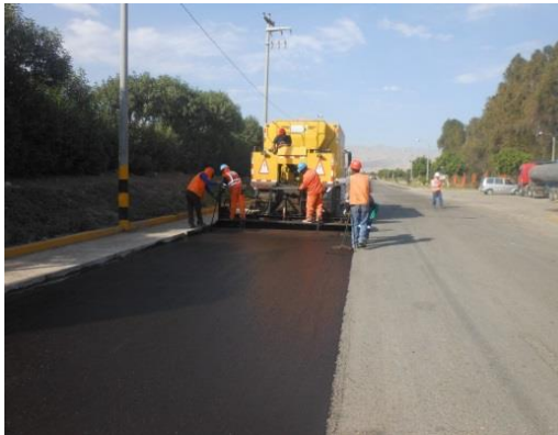
Figura 98. Aplicación del slurry seal en lado derecho de la berma con uso de camión micropavimentador en la Av. Malecón Ribereño, progresiva 1+160 @ 2+160
