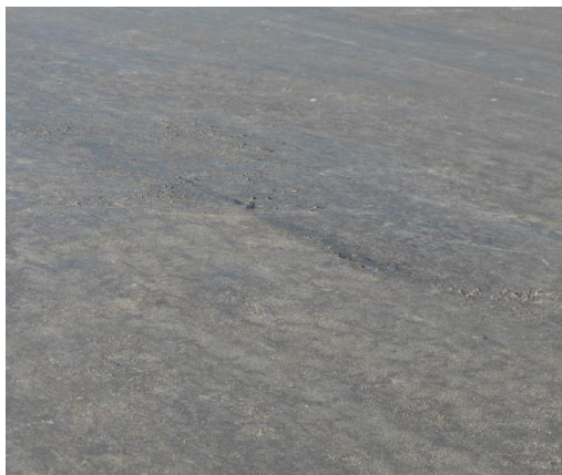
Figura 42. Segundo tipo de daño denominado ahuellamiento ubicado en la progresiva 1+645
