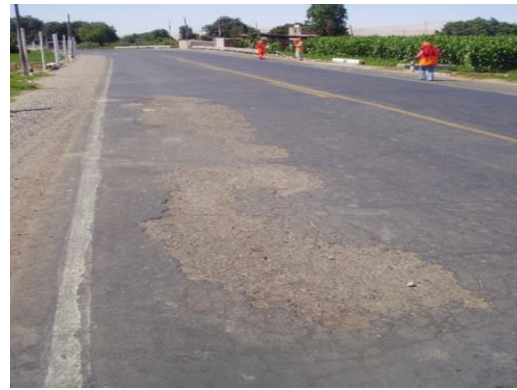
Figura 52. Tercer tipo de daño denominado desprendimiento ubicado en la progresiva 3+360
