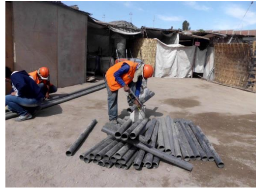
Figura 101. Cortado de tubos de PVC y preparación de los postes delineadores
