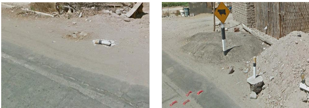
Figura 56. Mal estado de los postes delineadores ubicado entre la progresiva 3+500 a la progresiva 4+300
