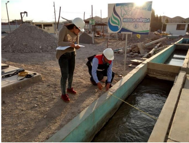
Figura 22. Medición de la sección del canal
