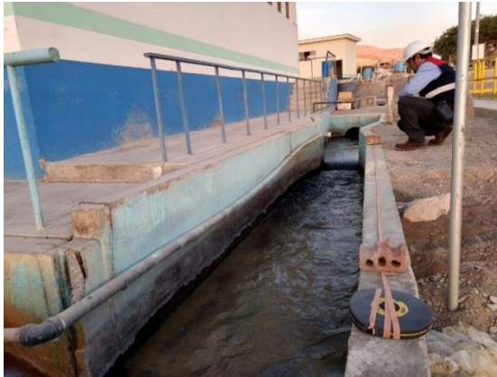
Figura 28. Medición de la longitud del canal
