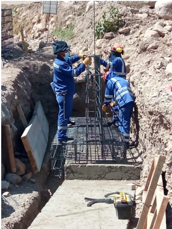
Armado de acero de refuerzo de muro de contencion
