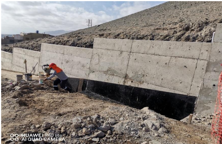
Imagen de Imprimación Asfáltica Manualmente
