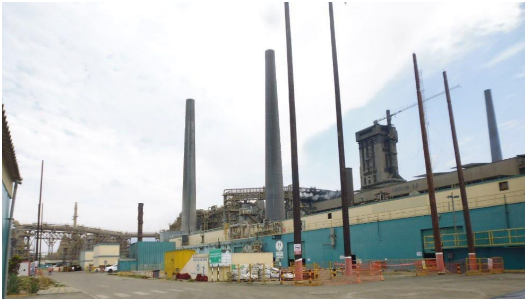
Central Térmica Ilo 1
