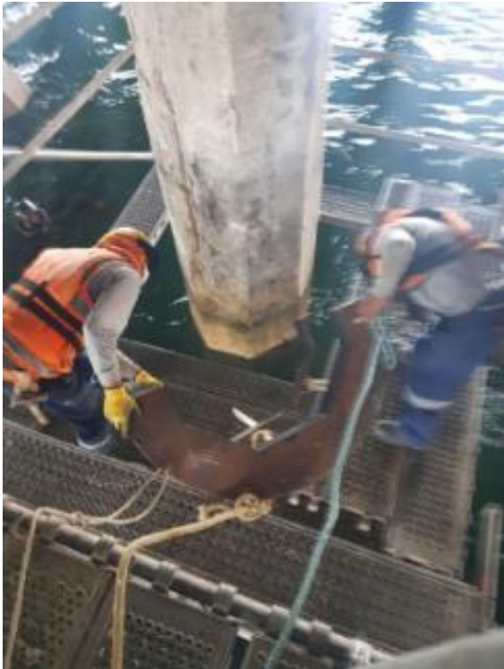
Colocación de Abrazadera de soporte para encofrado metálico.
