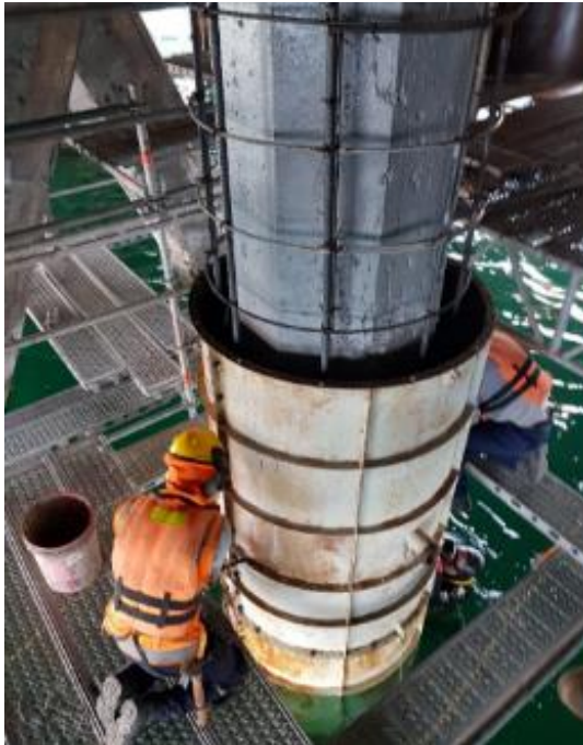
Encofrado metálico de Pilote.
